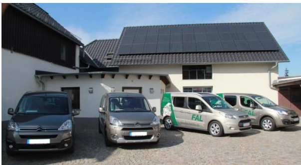
FAL Solaranlage © FAL
