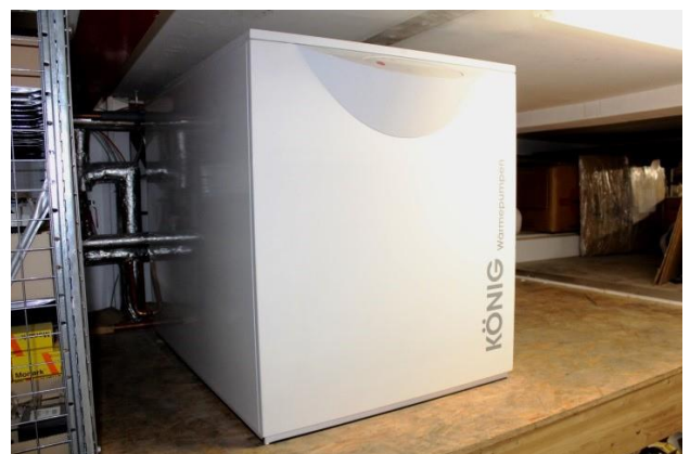
Sole Wärmepumpe © FAL
