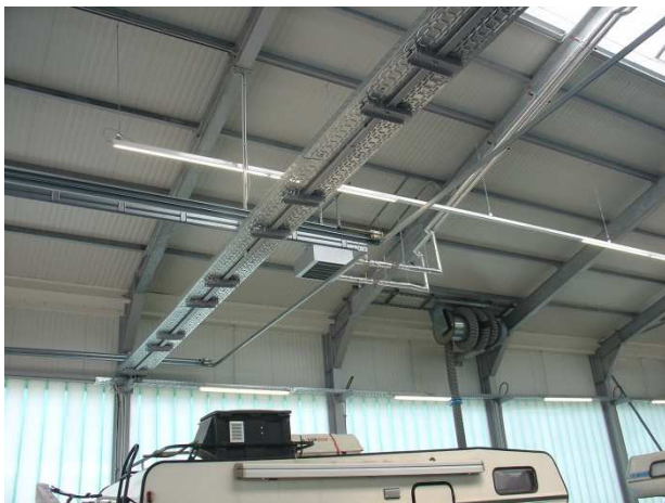
Innenansicht Werkstatthalle mit neuem Dach und Verglasung mit integriertem Vlies © Saar-Lor-Lux Umweltzentrum GmbH
