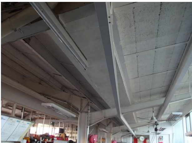
Werkstattdach Innenansicht: „Schmetterlingsdach“ mit darüber befindlichen Pultdach © Saar-Lor-Lux Umweltzentrum GmbH
