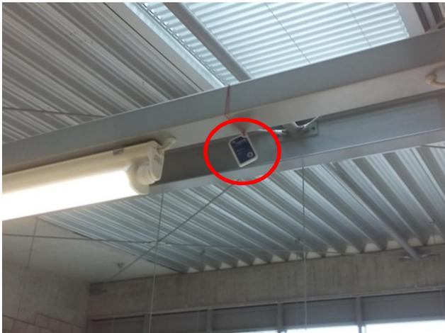
Einsatzbeispiel eines Datenloggers zur Raumtemperaturüberwachung
