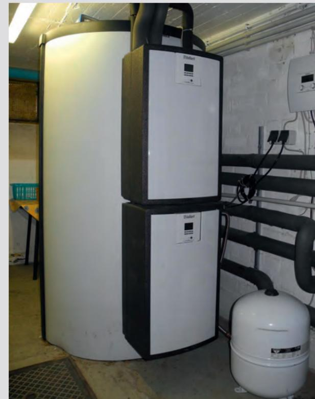
900 Liter Solarspeicher gewährleistet hauptsächlich regenerative Warmwasserversorgung
