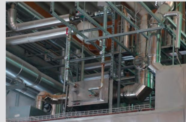
Wärmetauscher auf einem Backofen
