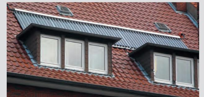
Solaranlage zur Brauchwassererwärmung im Friseurbetrieb Bußmann
