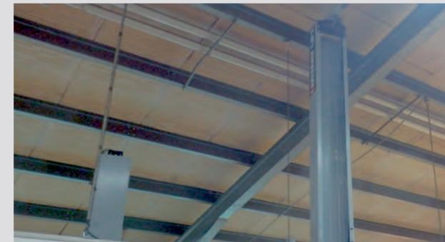
altes Wellasbestdach mit Styroporverkleidung
