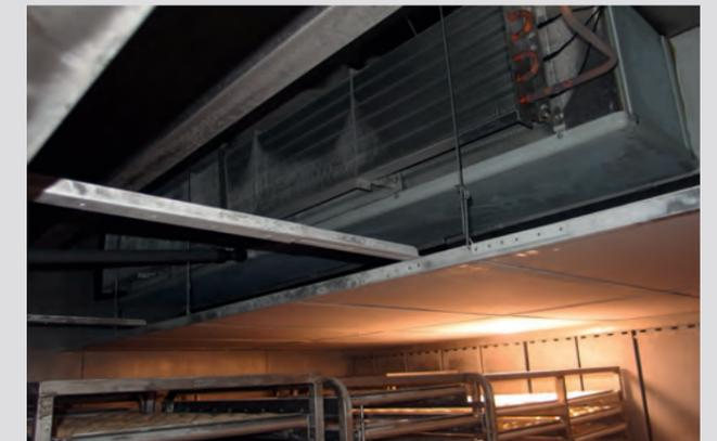
Gärkammer mit Heizung aus Abwärmenutzung
