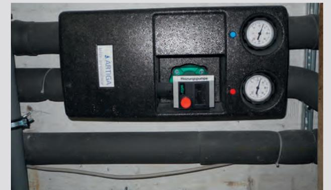
Vorbildlich gedämmte Heizungspumpe und Rohrsystem im Betrieb Bußmann
