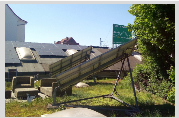
Gründach und Solaranlagen der Fa. Heinz Ewald © Handwerkskammer Hannover
