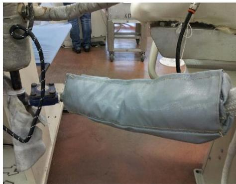
Eine interessante Neugigkeit, die noch genauer zu prüfen ist: Nachträgliche Isolierung von flexiblen Anschlüssen mittels Isoliermanschette, welche mit Klettverschluss befestigt werden kann.
