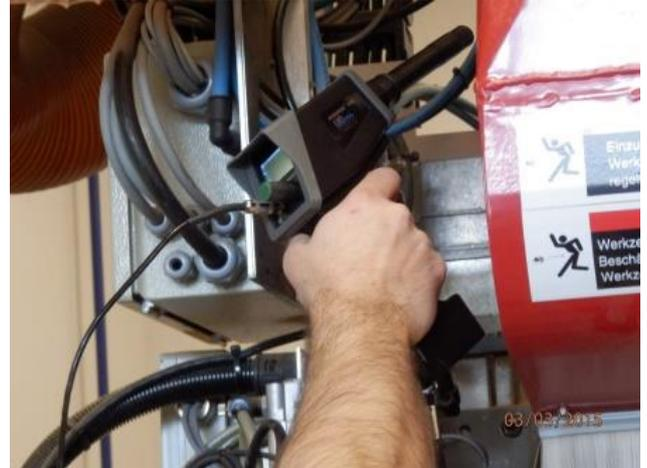
Ultraschallmessung an einer Druckluftleitung
