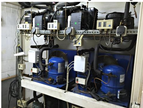
Kältekompressoren © Handwerkskammer für Ostthüringen
