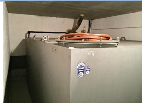
Alter Heizöltank © Handwerkskammer für Ostthüringen
