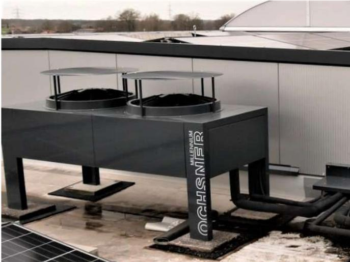
Horizontal-Split-Verdampfer der Wärmepumpe.
