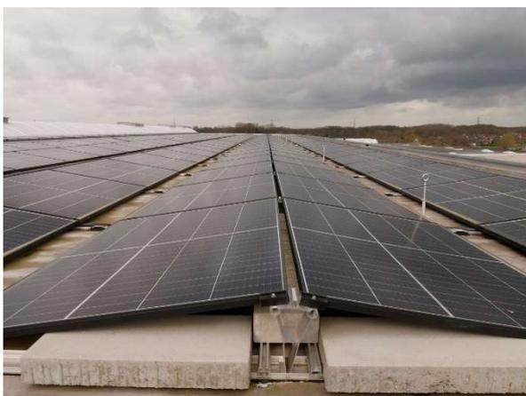
Auf dem Flachdach wurden Photovoltaik-Module mit einer Leistung von 300 kW<sub>p</sub> flach aufgeständert. Die selbst erzeugte Energie übersteigt den eigenen Strom-Bedarf für die Beheizung des Gebäudes mit einer Wärmepumpe und für die Produktion. So ist der Betrieb resistent und zukunftssicher aufgestellt und braucht steigende Energiepreise nicht zu fürchten.
