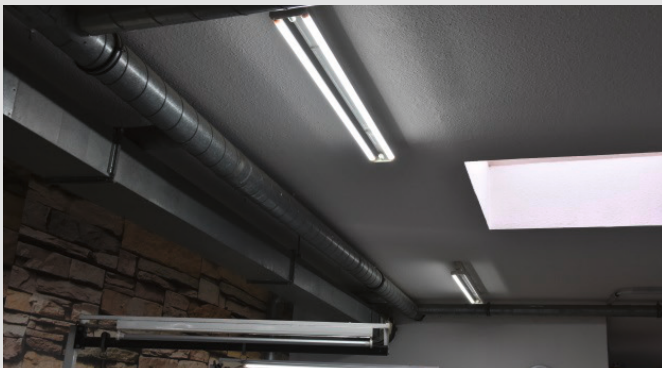
Bestandsanlage mit LED-Tubes © Handwerkskammer zu Leipzig
