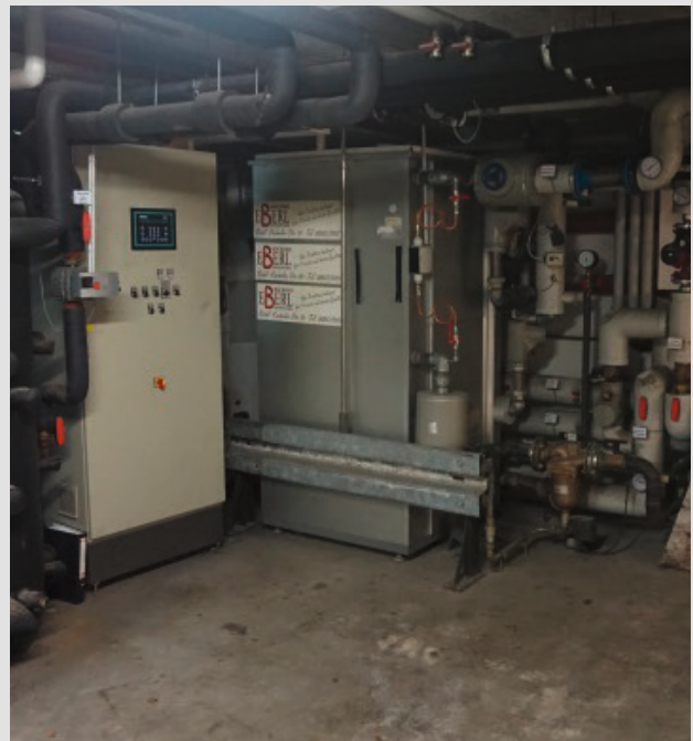
Ein Blick auf die Absorptionskälteanlage © Dirk Bräu, Handwerkskammer für München und Oberbayern
