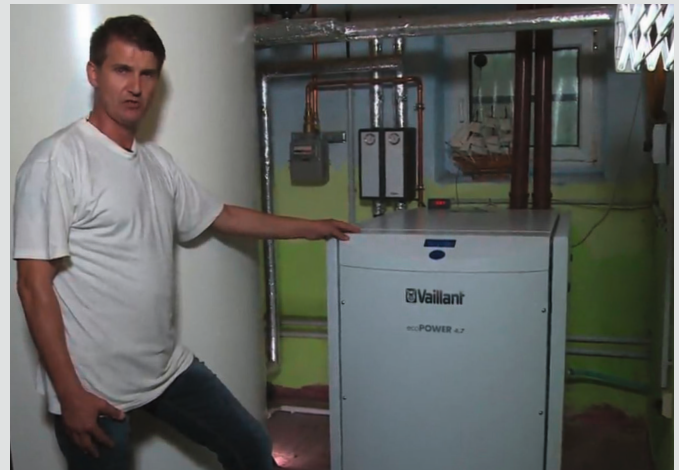
BHKW und Pufferspeicher © VKU Verband kommunaler Unternehmen e.V.
