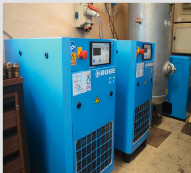
Neue Druckluftstation © Handwerkskammer zu Leipzig
