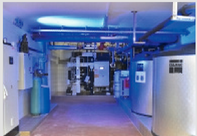
Blick in die Anlage der Absorptionskältemaschine © Karmelitenbrauerei Straubing
