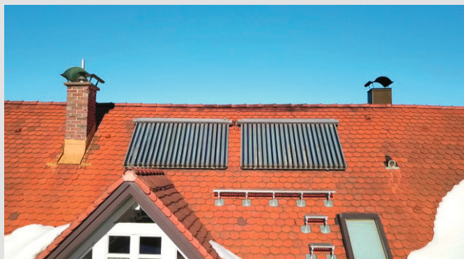
Röhrenkollektoren zur Unterstützung der Warmwasserbereitung © M. Tröbelsberger
