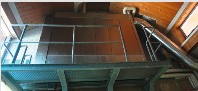
Rauchgaswaschanlage reduziert auch den CO 2 -Ausstoß der Abgase © Dirk Bräu, Handwerkskammer für München und Oberbayern
