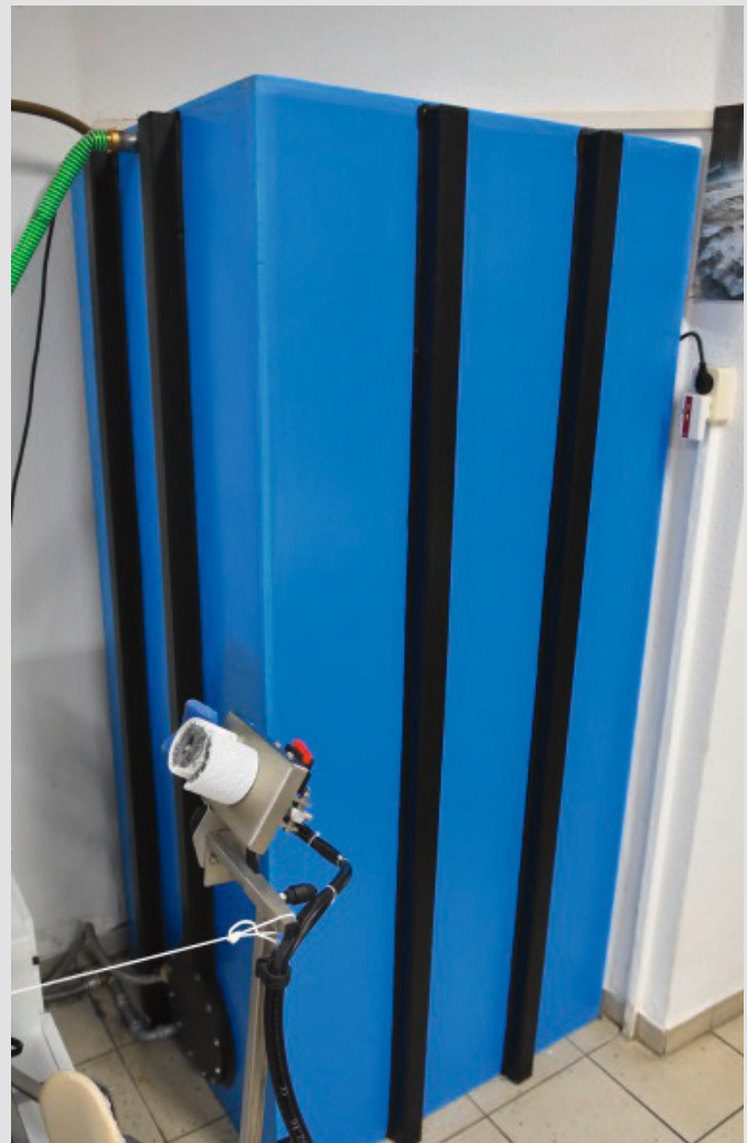
In Raumecke eingepasster 700-Liter-Tank mit dreieckiger Grundfläche © Handwerkskammer zu Leipzig
